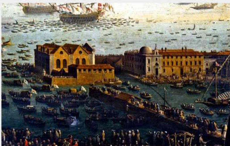
La darsena, adeguata al servizio del cantiere e dell'arsenale
